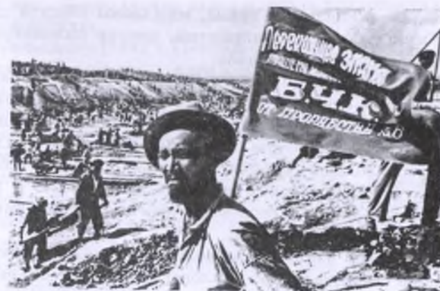
Строительство Большого Чуйского канала.
