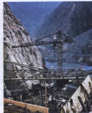
Строительство Токтогульской ГЭС
